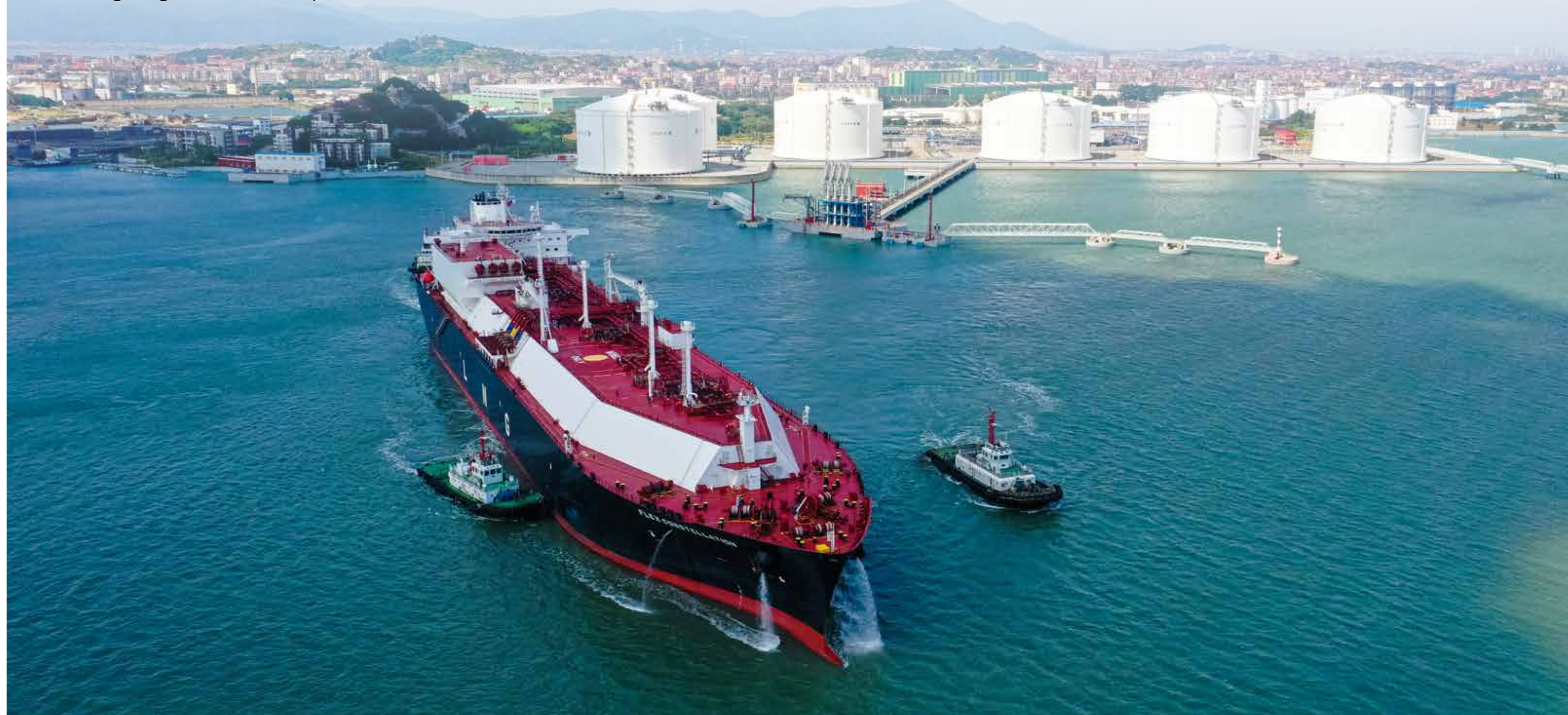
Fujian LNG Receiving Terminal - Courtesy CNOOC
