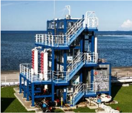
OTEC Demonstration Facility (Kumejima)
